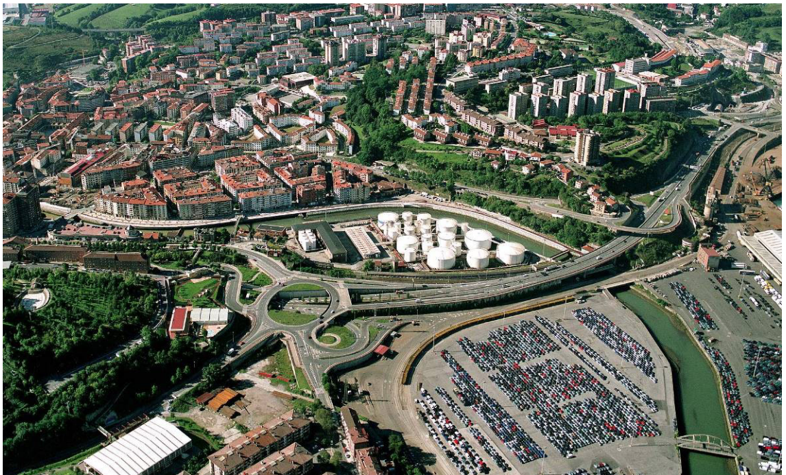
3.1.3. Vista aérea general de Errenteria. En primer plano; el Ámbito de Altzate y parte del Puerto de Pasaia.
