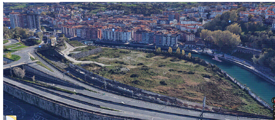
Vista general de Alzate y el barrio de Iztieta al fondo
