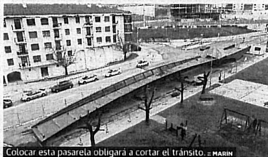
Colocar esta pasarela obligará a cortar el tránsito. :: MARIN
