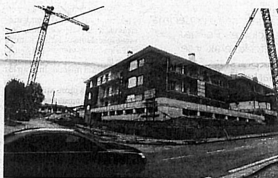
Sector 1. Las viviendas se siguen construyendo. :: ARIZMENDI
