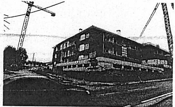
Sector 1. Las viviendas se siguen construyendo. :: ARIZMENDI
