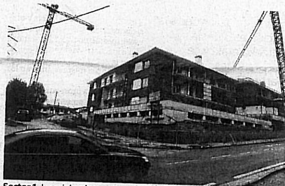
Sector 1. Las viviendas se siguen construyendo. :: ARIZMENDI
