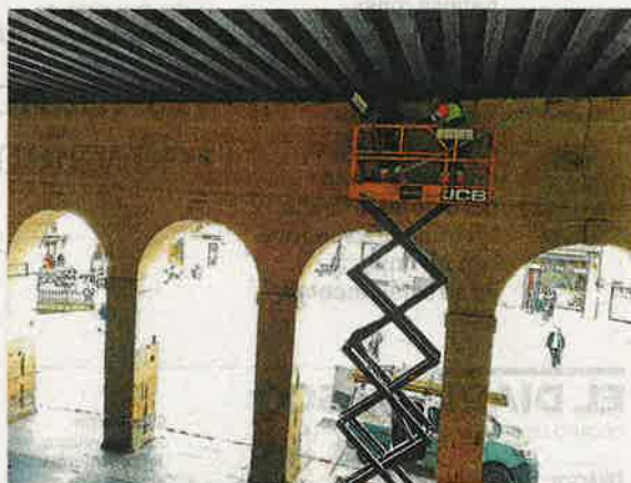
Operarios trabajando en el cambio de los focos en Kontzejupe.
