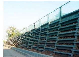
Figura 17: Pantalla acústica de caballones de tierra
