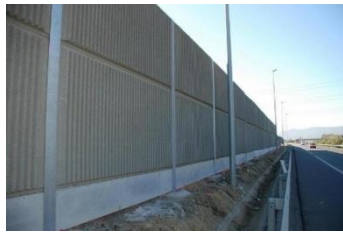
Figura 15: Pantalla acústica de hormigón
