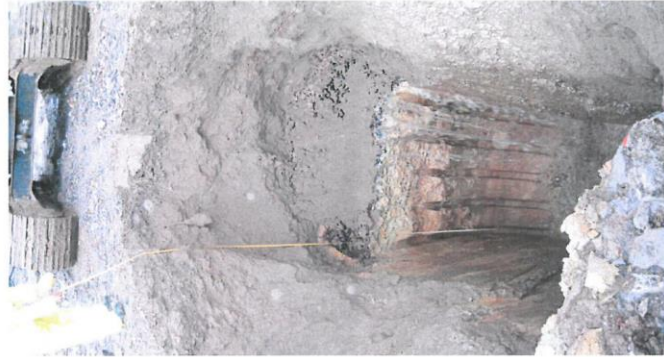
CALICATA C-6 PROFUNDIDAD FINAL = 5,50 MTS.
