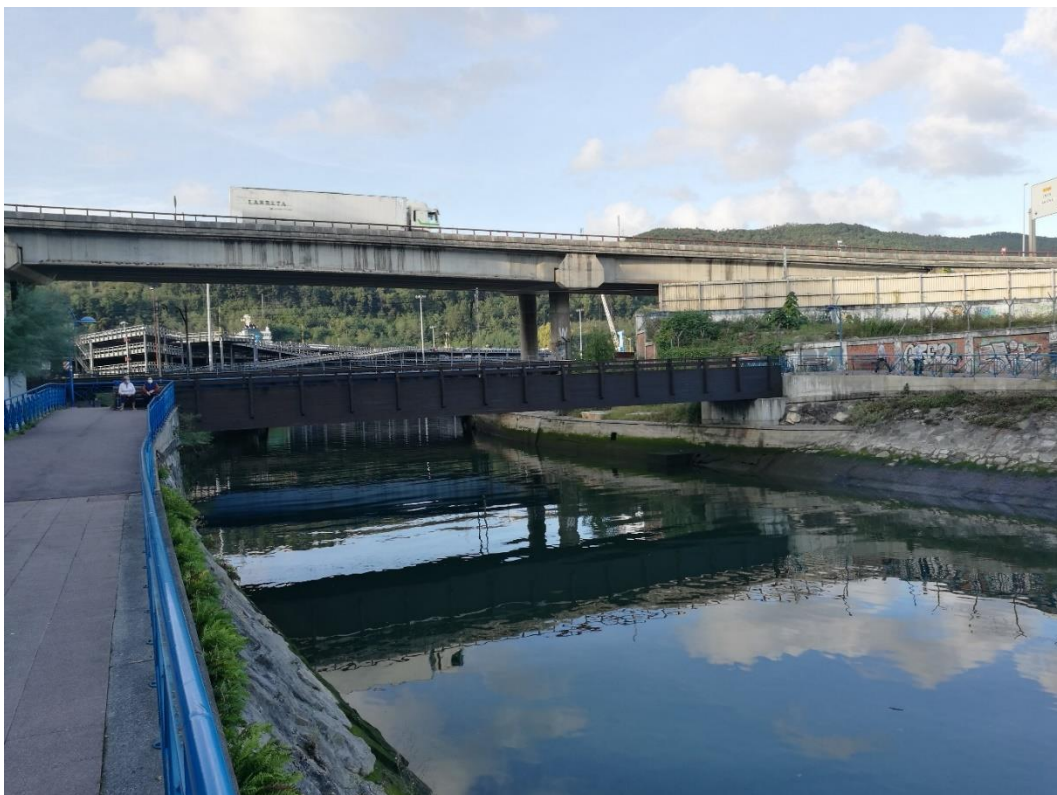
Fotografía 12: Pasarela peatonal existente al final del ámbito
