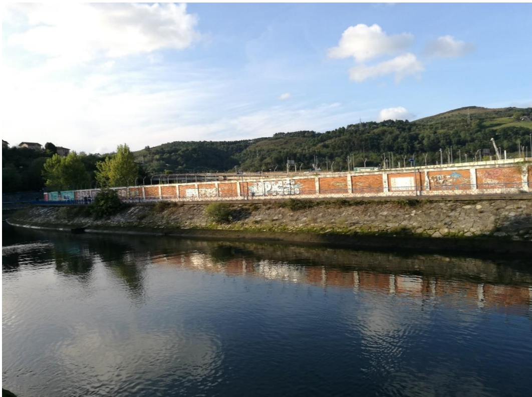
Fotografía 4: Escollera existente en la margen de Altzate
