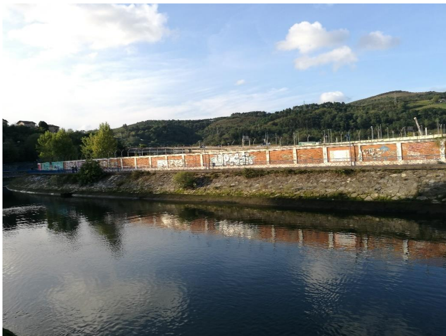
Fotografía: Escollera existente en la margen de Altzate
