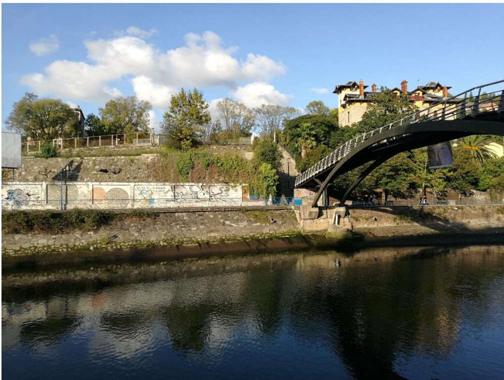
Fotografía nº2: Estribo de la pasarela aguas abajo
