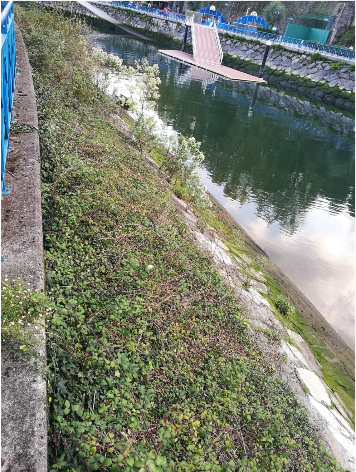
Fotografía 14: Detalle de vegetación en la parte alta de la escollera
