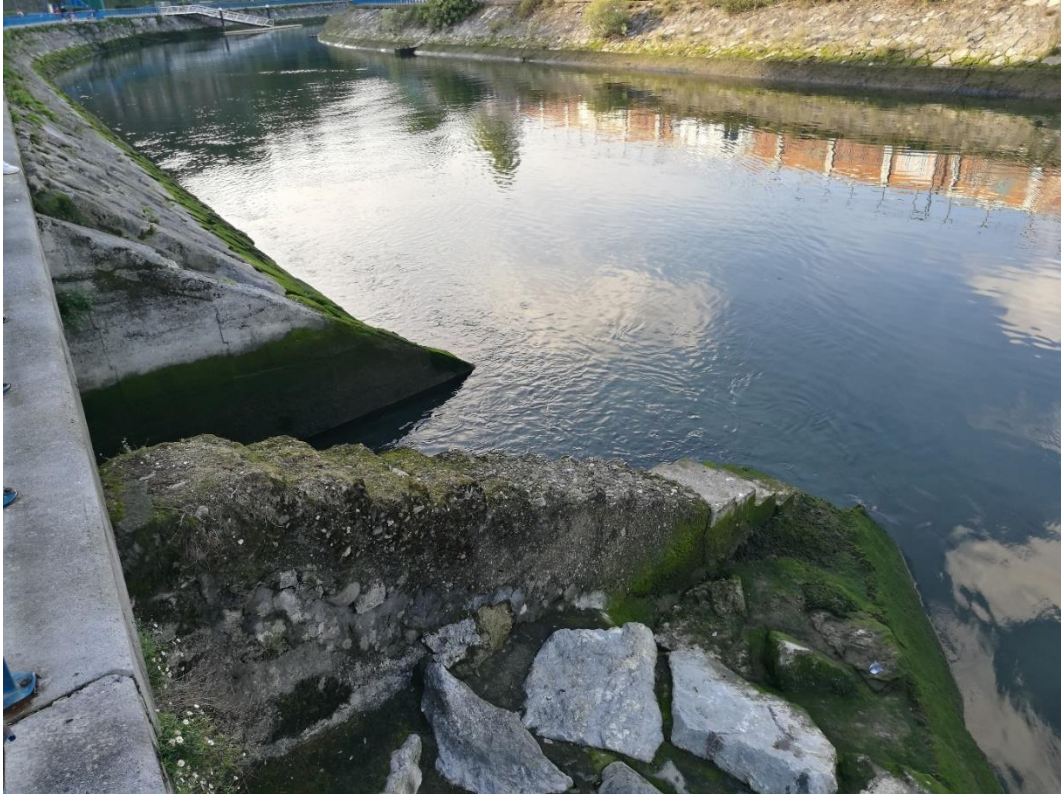
Fotografía 7: Salida de regata en la margen de Iztietla. Coincide con la ubicación del puente proyectado.
