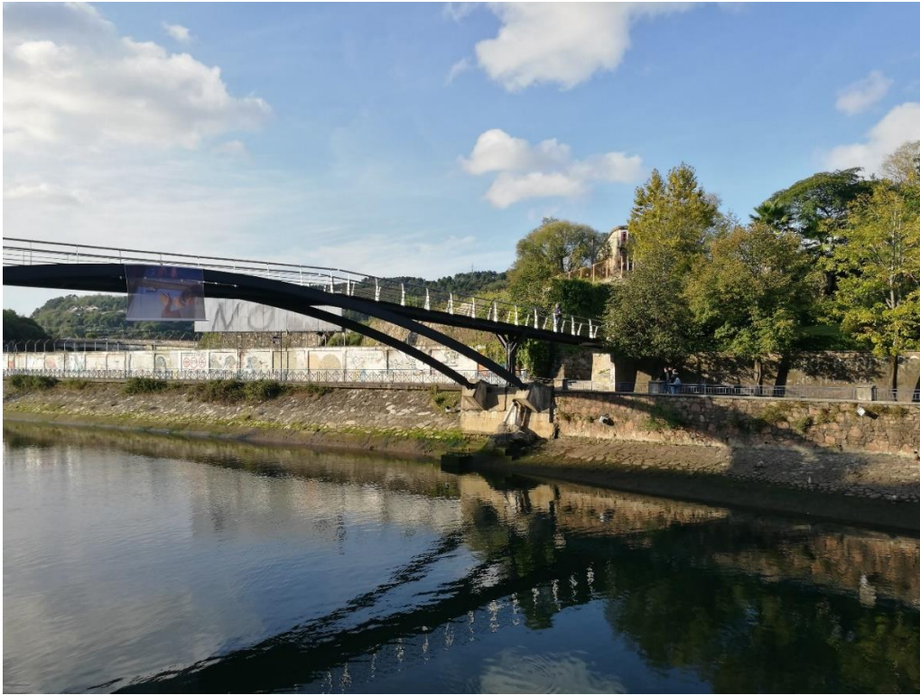
Fotografía 1: Pasarela existente aguas arriba del ámbito
