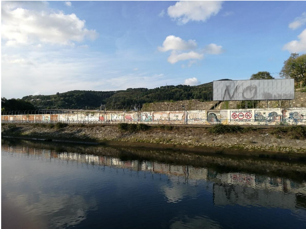
Fotografía 3: Escollera existente en la margen de Altzate
