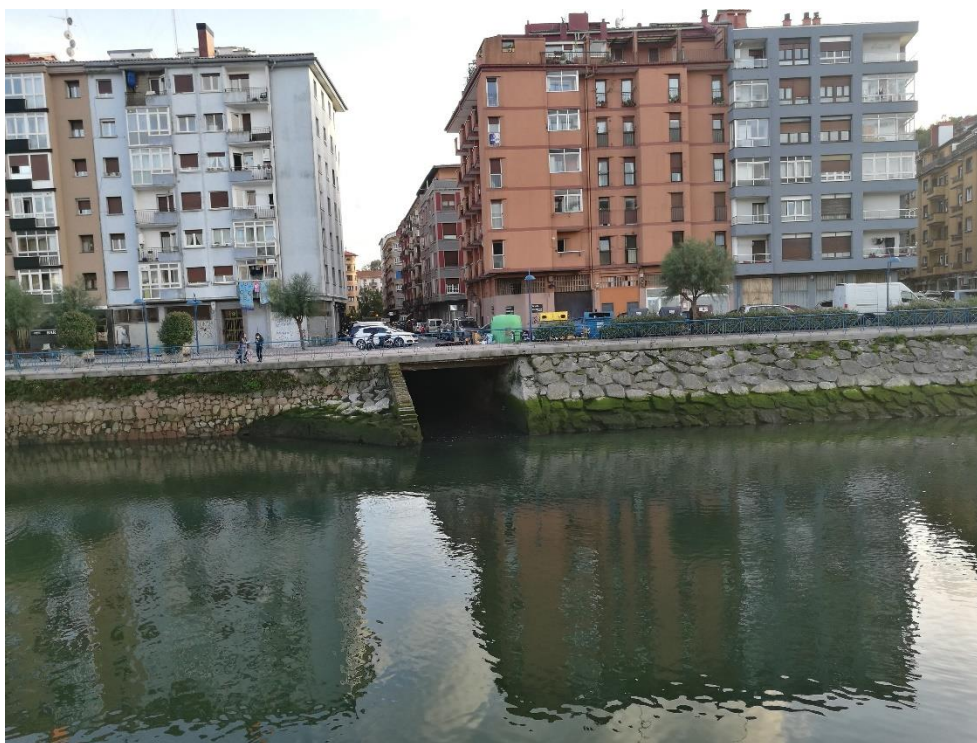
Fotografía: Salida de tajea a modificar para la construcción del puente.
