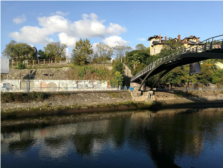
Fotografía: Pasarela existente al comienzo del ámbito (a la altura de Hondarribia Kalea)
