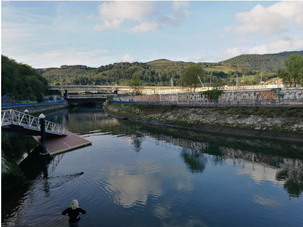
Fotografía 9: Pantalán existente en la margen de Iztieta (aguas arriba)
